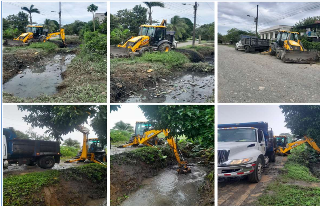
LIMPIEZA DE CANALES EN CUADRANTE DE SIXAOLA C7-04-109
