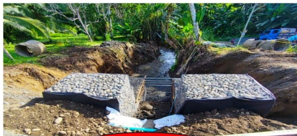
AVANCE PASO 1 DE ALCANTARILLA Y MURO DE GAVIÓN EN CARBON 1
