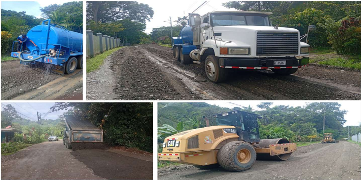
RECUPERACION, CONFORMACION Y COMPACTACION DE LA SUPERFICIE DE RUEDO
