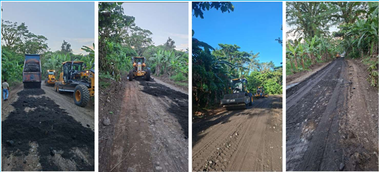
COLOCACION DE LASTRE, NIVELACION, COMPACTACION Y CONFORMACION DE SUPERFICIE DE RUEDO
